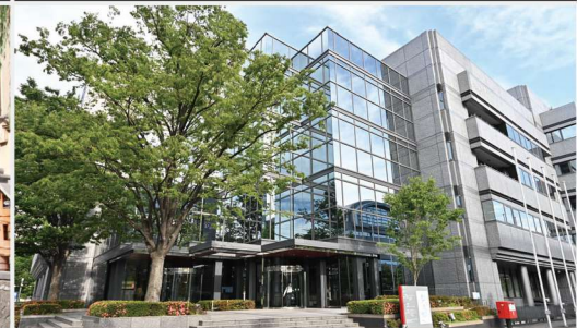
京都リサーチパーク
